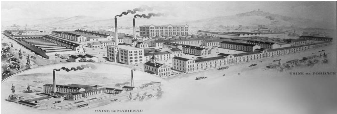
L'usine de Forbach
